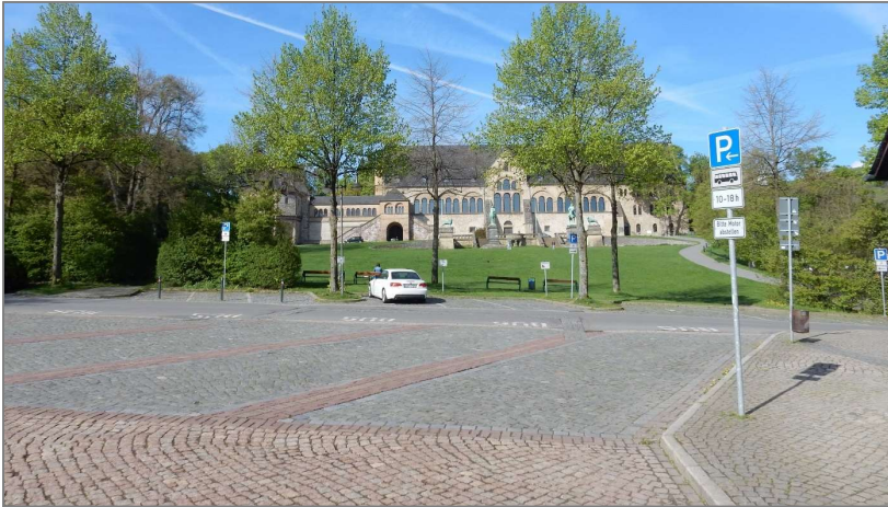
Abbildung 4-20: Areal des Parkplatzes Domplatz nahe der Kaiserpfalz Quelle: [WVI 2018]
