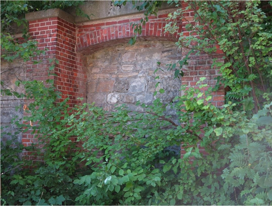
Abb. Denkmalgeschützte Feldmauer an der Südgrenze des Grundstückes
