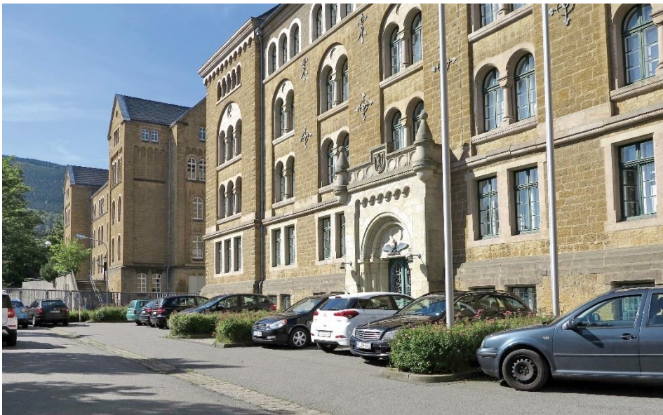
Abb. Amtsgericht im denkmalgeschützten, ehemaligen Kasernengebäude
